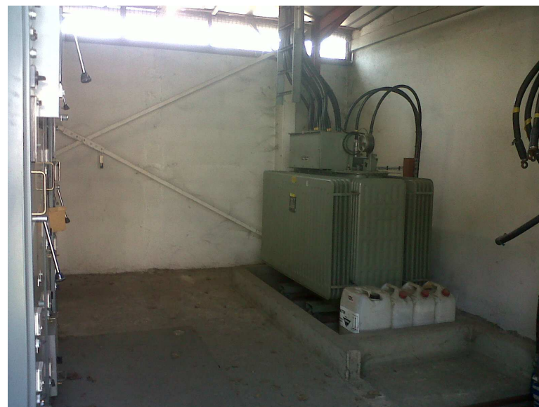
Transformateur au pyralène dans un local de la zone « 616 »
