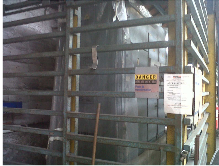
Vues du transformateur récent de remplacement du transformateur historique au pyralène dans la zone de « colisage »
