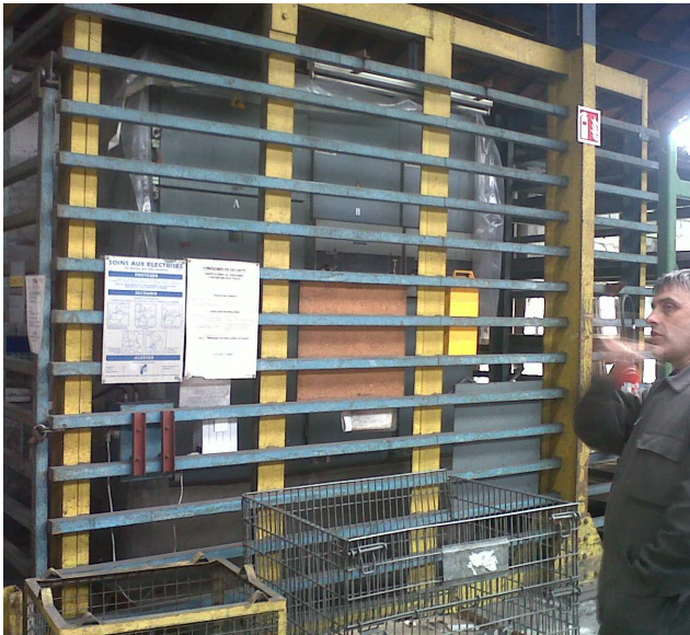
Vues du transformateur récent de remplacement du transformateur historique au pyralène dans la zone de « colisage »
