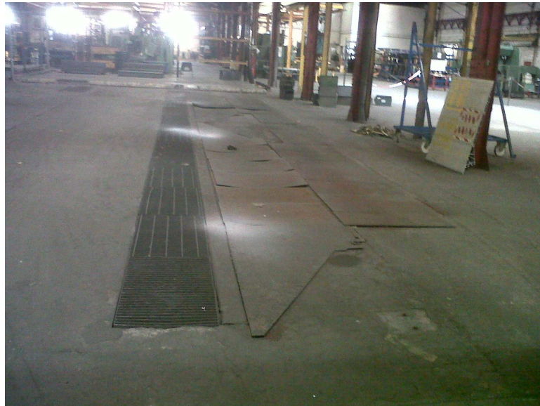
Vue des fosses de l'ancienne cabine de peinture
